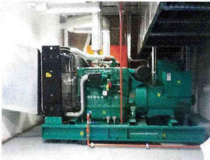
El grupo para generación eléctrica se conforma en configuración 2N, con una capacidad total de 3 MVA con generadores de 500KVA efectivos a la altura de Bogotá. El generador incluye un panel de control electrónico modular, con sistema de monitoreo por microprocesador.
